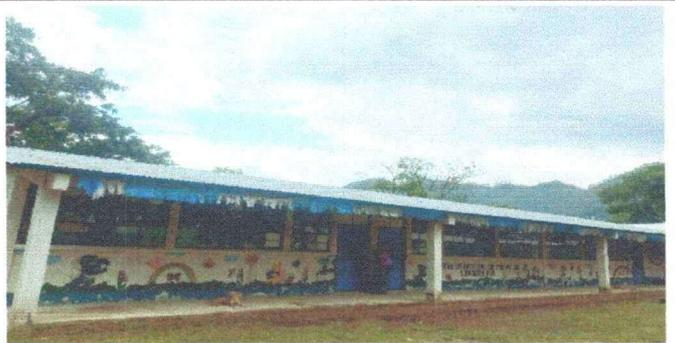
Foto 6: se necesita cambiar cubierta de lamina en las aulas
